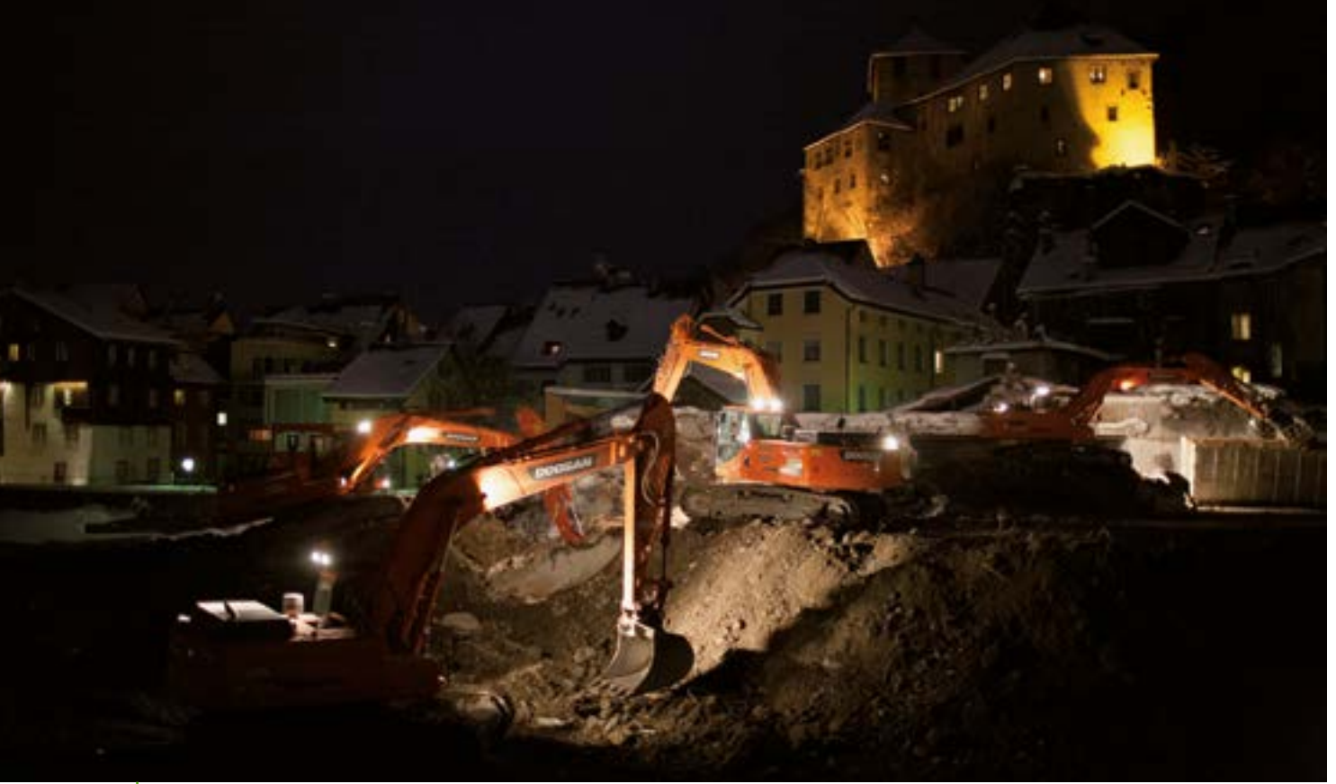
Montforthaus, Feldkirch. Schadstoffsanierung, Entkernung, Abbruch von 44.000 m 3 und Tiefenenttrümmerung in nur 5 Wochen.
