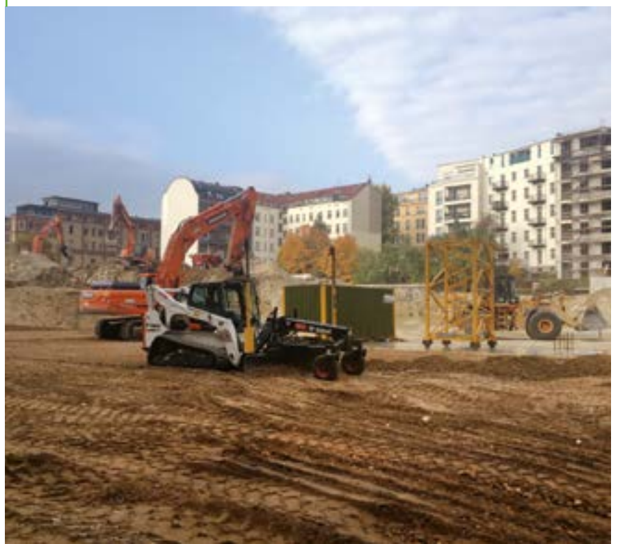
La Vie, Berlin. Erdbau und Tragschicht einbauen. Abbruch 120.000 m 3 UR, 110.000 t Aushub, 60.000 t Recyclingherstellung.
